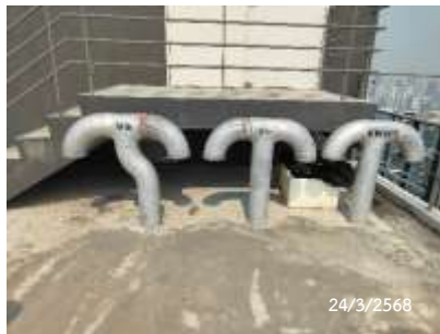
ท่อระบายอากาศชั้นดาดฟ้า
